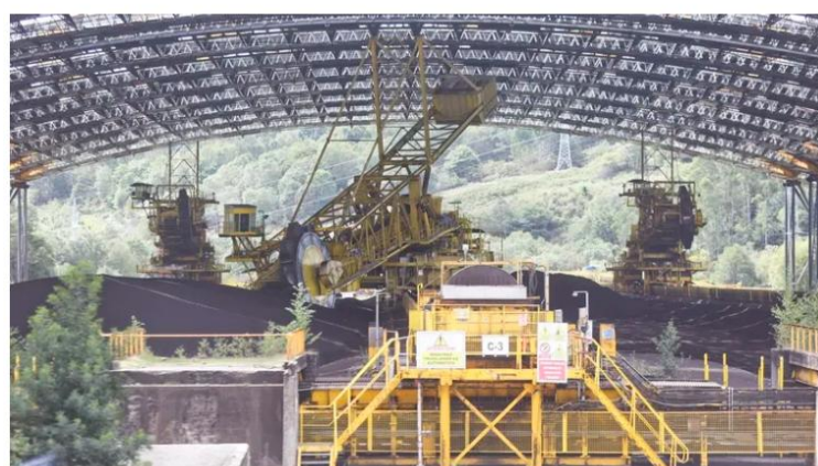
La fábrica de Ence estará situada en el parque de carbones de la central de As Pontes, arriba, en foto de archivo JOSE PARDO
